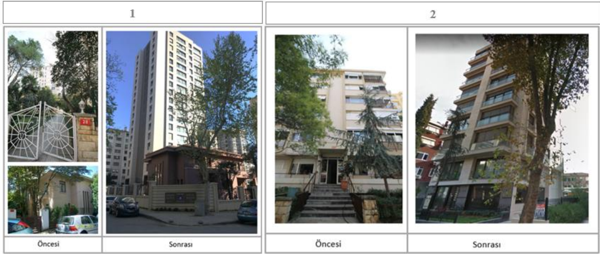
Şekil 4. Hasan Ali Yücel Sokak Kentsel Dönüşüm Eski-Yeni Bina Görünümleri
